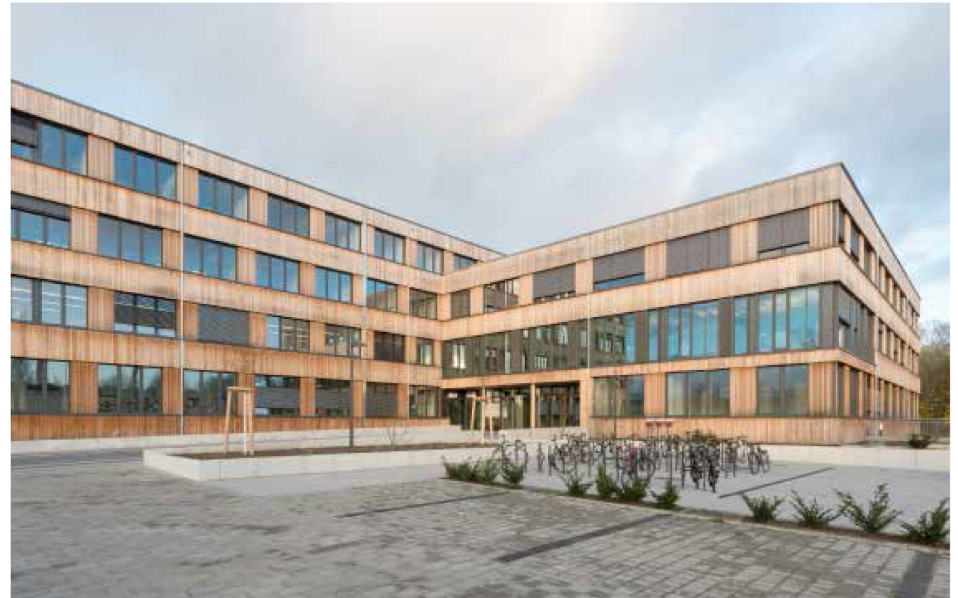
Stufenweise erweiterbarer Holz-Beton-Hybridbau mit vorgehängter Holzrahmen-Fassade aus Holz.
