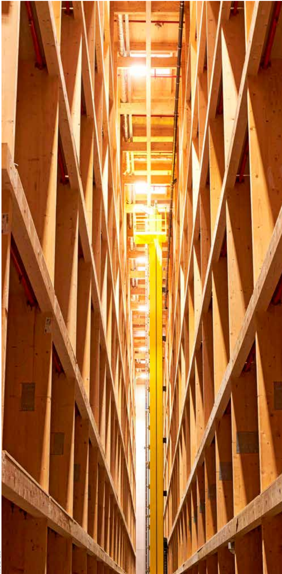
Das 31 m hohe Hochregallager ist für ca. 17 200 Paletten ausgelegt
